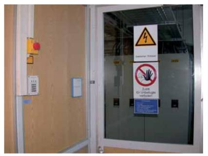
**Bild 9** Zugang zu einem Dauerversuchsraum, Kennzeichnung der Zugangstüre, Zugang mittels codierter Türverriegelung nur für befugtes Personal
