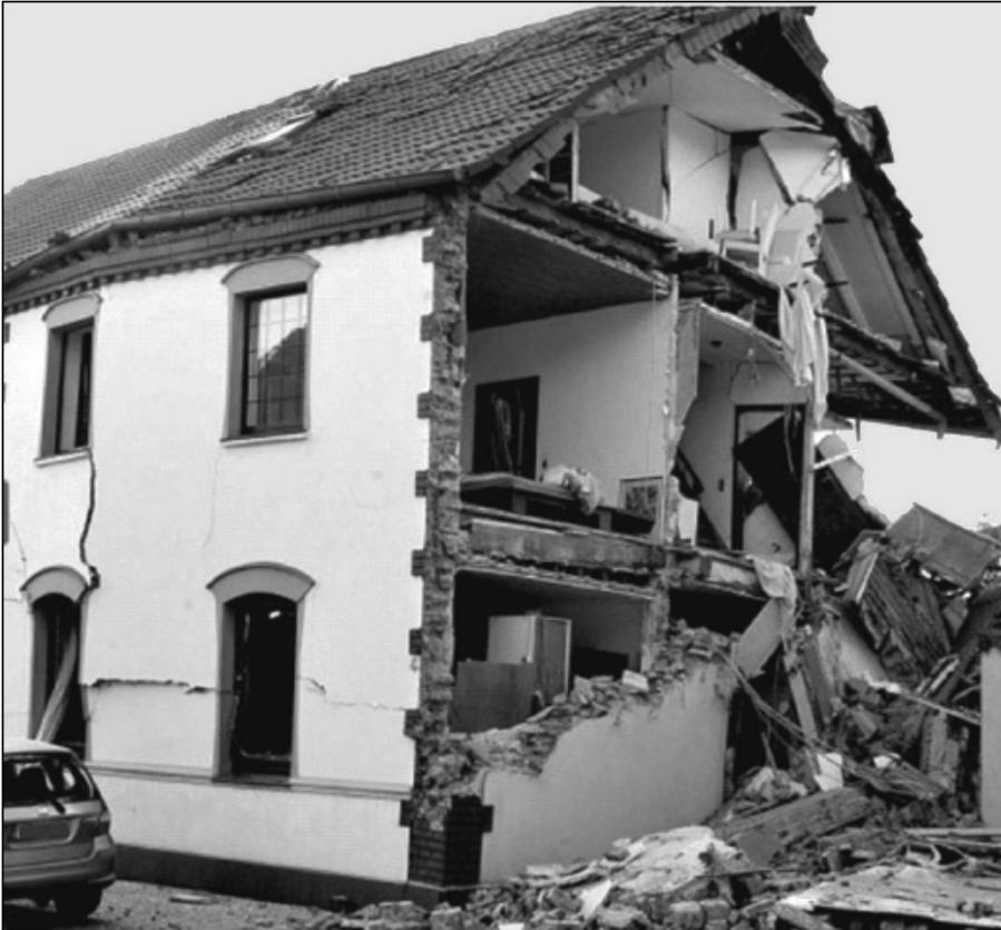
Abb. 6: Zerstörungsbild nach einer Gas-Explosion
