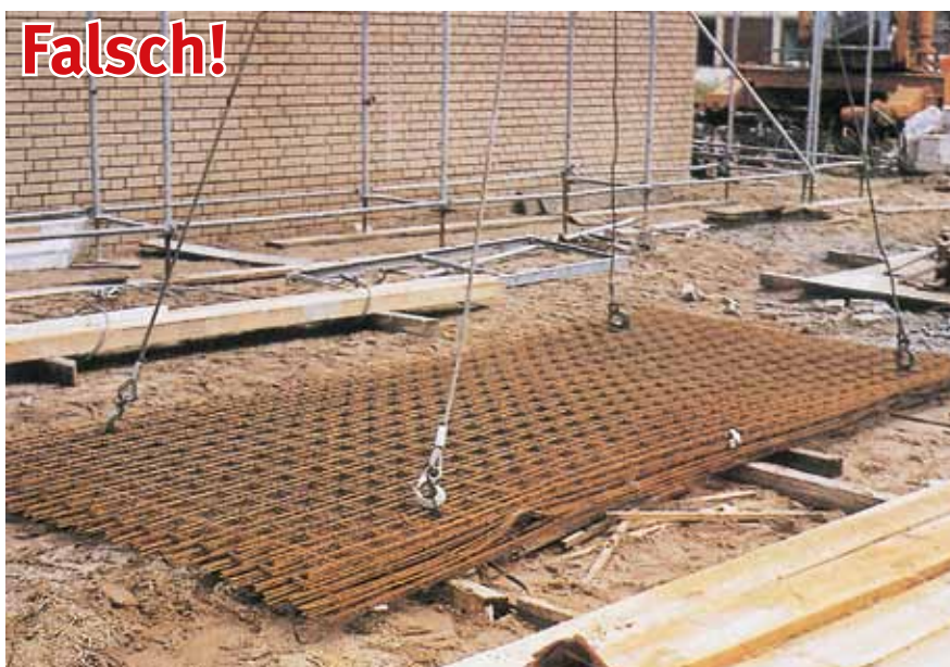
Bild 16-5: Einhängen in die Umschnürung ist lebensgefährlich!
