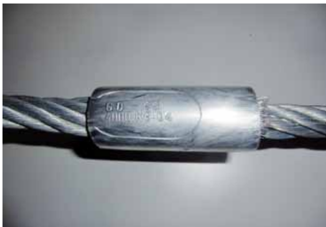
Bild 9-1: Pressklemme mit Verpresserkennzeichen
