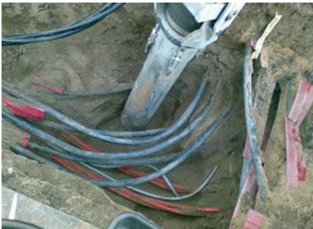
Abb. 9 Saugrohr im Einsatz
