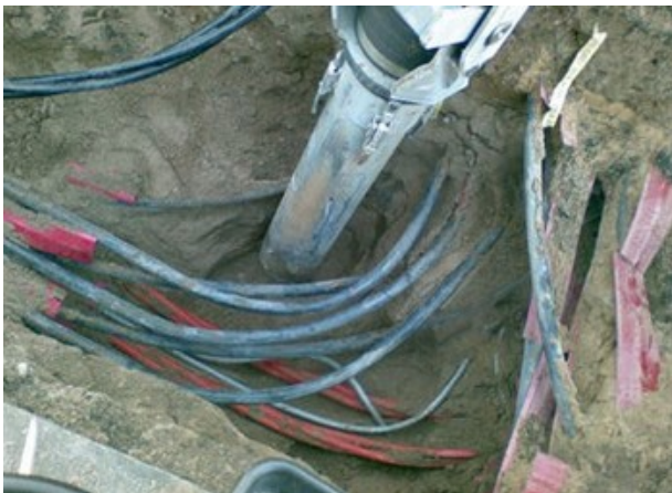
Abb. 9 Saugrohr im Einsatz
