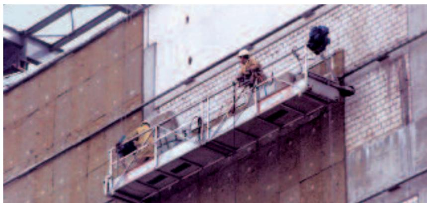
**Hochziehbare Personenaufnahmemittel (PAM)** sind Einrichtungen, die mit dem Tragmittel des Hebezeuges verbunden sind, durch Hebezeuge bewegt werden und zur Aufnahme von Personen dienen (Personenförderkörbe, Arbeitskörbe, Arbeitssitze, Arbeitsbühnen).
