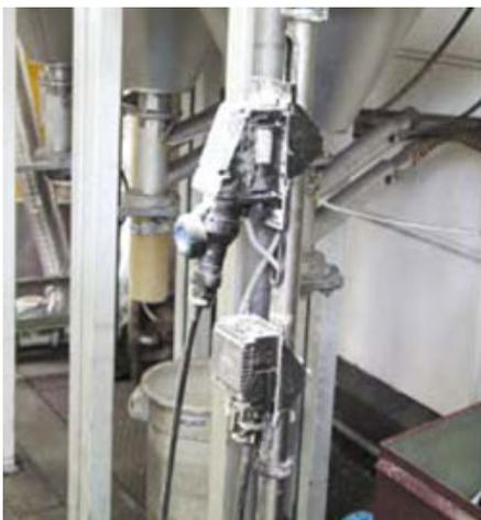
Bild 10-8: Elektrische Steckverbindung in explosionsgefährdetem Bereich
