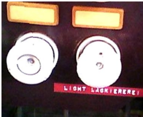
Abb. 24.1 Verteilung mit Diazed-Sicherungen
