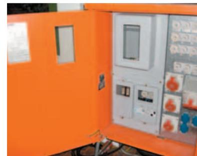
Bild 4-2: Kleinstbaustromverteiler
