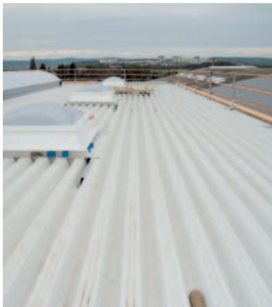
Bild 5-11: Mobiler temporärer Seitenschutz (Fa. Kee Klamp)
