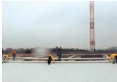
*Bild 5-18: Schutznetze unter einem Lichtband*
