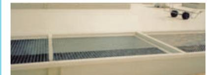
*Bild 5-28 Absturzsicherung für Lichtkuppeln (Fa. Kee Klamp)*
