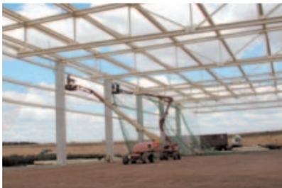
*Bild 5-23: Aufhängung der Netze mittels seilunterstütztem Arbeiten/Alpintechnik (nur in Sonderfällen)*
