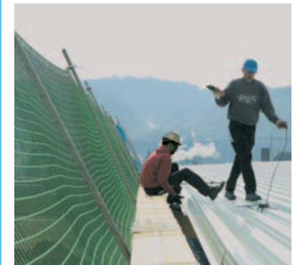
Bild 5-9: Randsicherungen mittels Schutznetzen an den Gebäudeaußenkanten, Beispiel 2
