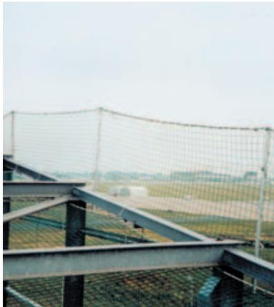
Bild 5-10: Dreiteiliger Seitenschutz als Absturzsicherung
