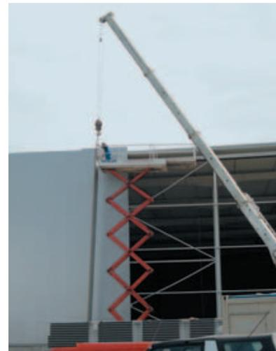
Bild 5-36: Überlastete Hubarbeitsbühne bei der Wandmontage
