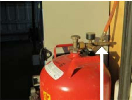
Abb. 6-3 Schlauchbruchsicherung
