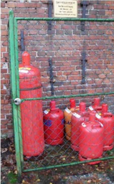
Abb. 8-2 Lagerung gefüllter Druckgasbehälter im Freien
