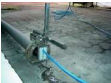
Abb. 3-8: Beispiel einer Fangvorrichtung bei der Rohrreinigung
