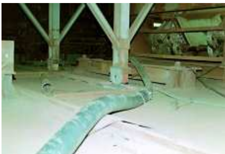
Abb. 3-14: Einfache Abfangung mit Seilschlinge gegen das unkontrollierte Umherschlagen des Schlauches
