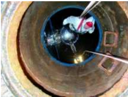
Abb. 3-17: Vorbereitende Arbeiten zur Kanalinspektion (Einsetzen der Rohrkamera)
