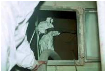
Abb. 6-1: Bei Saug- und Luftförder-Arbeiten sind statische Aufladungen möglich.
