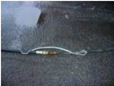
Abb. 3-6: Stahlseil als Schlauchsicherung gegen Umherschlagen bei Abriss.
