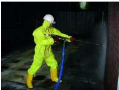
Abb. 3-4: Hochdruckreinigung mit Schulterstütze bei Rückstoßkraft \geq 150 N (Man beachte auch: Länge der Lanze, gemeinsame Schlauch- und Kabelführung, Gamaschen, Kopf- und Gesichtsschutz, richtige Handhaltung: linke Hand oben)
