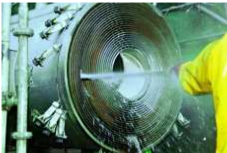
Abb. 3-2: Mechanische Reinigung (Beispiel: Hochdruck-Reinigung eines Wärmetauschers)
