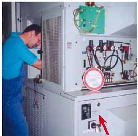
Bild 2-57: Sichere Störungsbeseitigung; Absicherung mittels Vorhängeschloss
