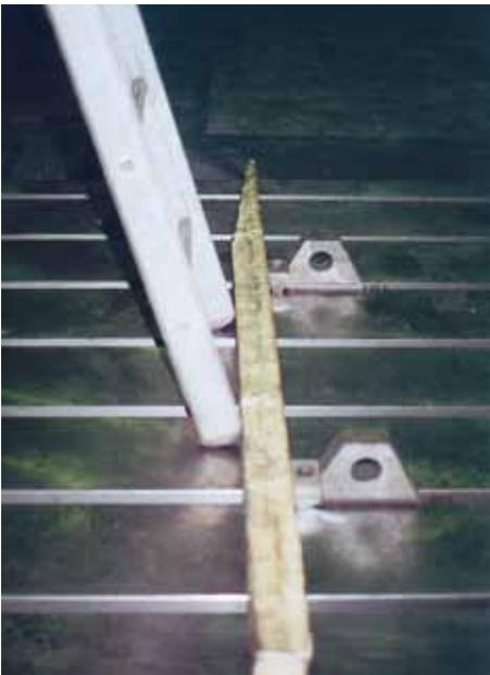
Bild 2-7: Ungeeignete Sicherung einer Leiter gegen Wegrutschen
