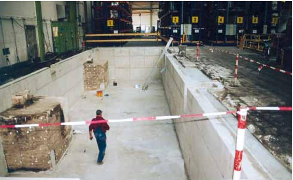
Bild 2-11: Unzulässige Maßnahme gegen Absturz (Flatterband) an der Fundamentgrubenkante
