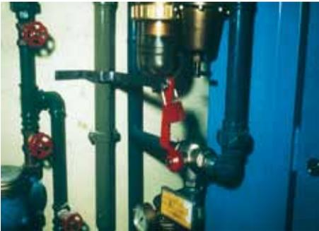
Bild 2-19: Abschließbarer Hauptschalter für die Pneumatik
