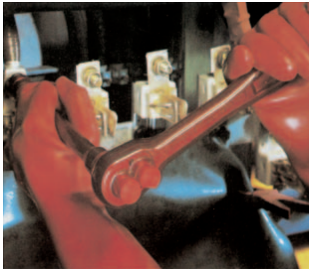
Bild 14-3: Anwendung einer Umschaltknarre mit Isolation nach VDE bei gleichzeitiger Benutzung von isolierenden Handschuhen und Abdeckung der übrigen Kontaktteile durch Isoliertuch
