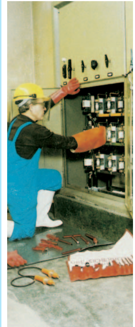
Bild 14-1: Arbeiten unter Spannung
