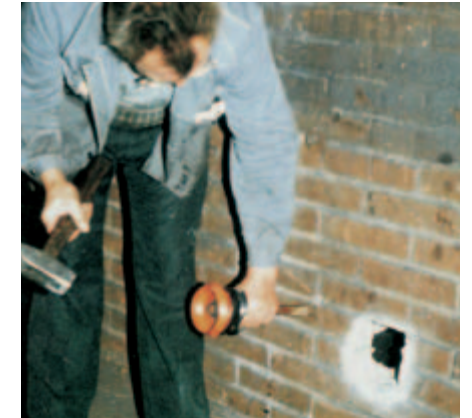
Bild 3-6: Bei Stemmarbeiten am Mauerwerk müssen Handschutz und Schutzbrille benutzt werden
