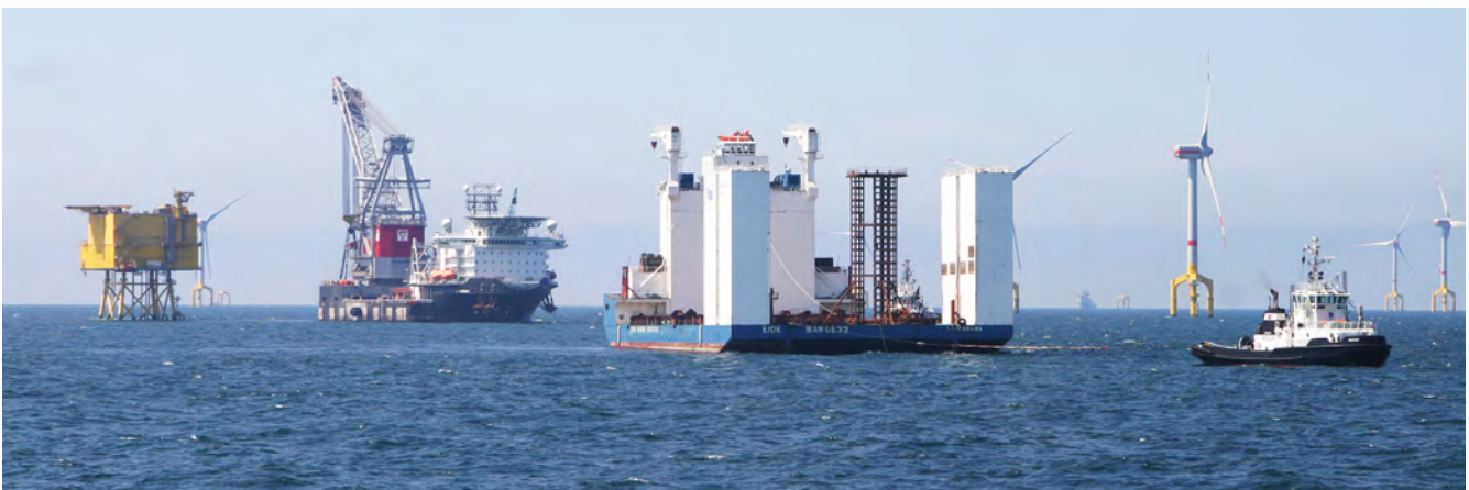
Abb. 1 Offshore-Windpark: Errichter- und Versorgungsschiffe, Plattform, WEA
