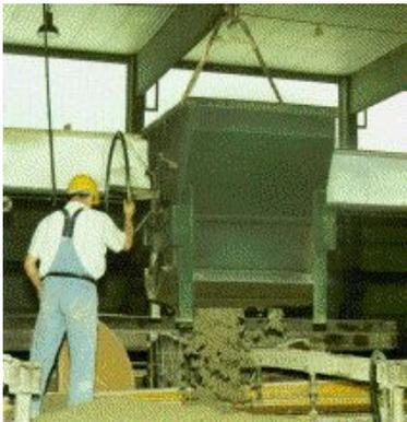
Abb. 5: Kran mit Betonkübel
