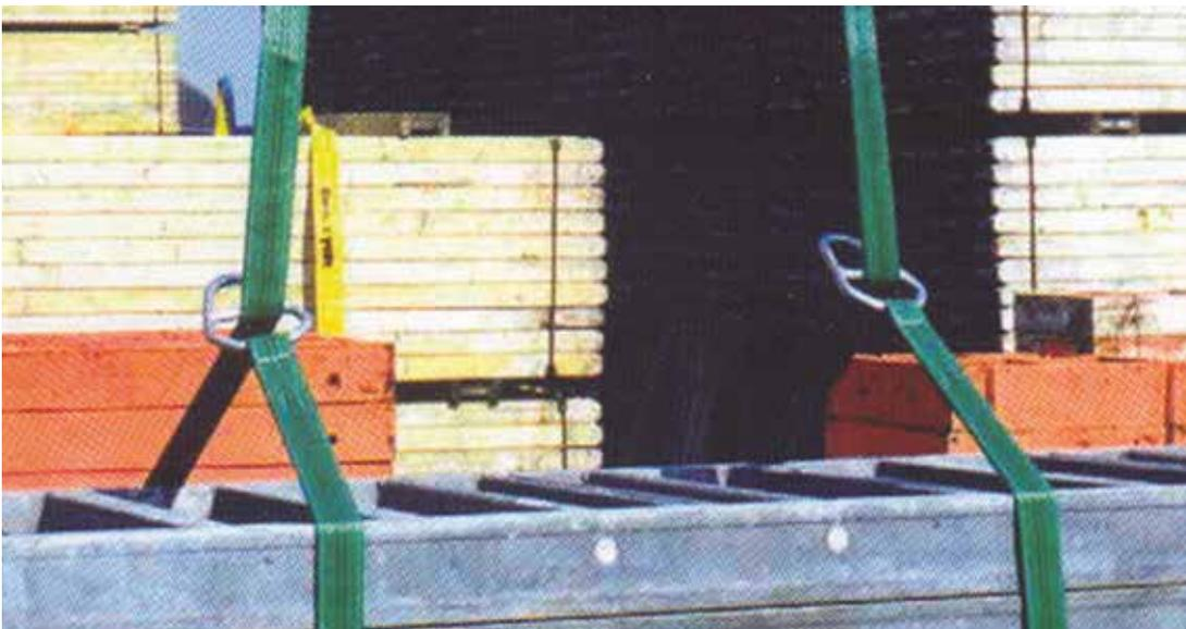
Bild 1-13: Sichere Auflage durch Beschlagteil
