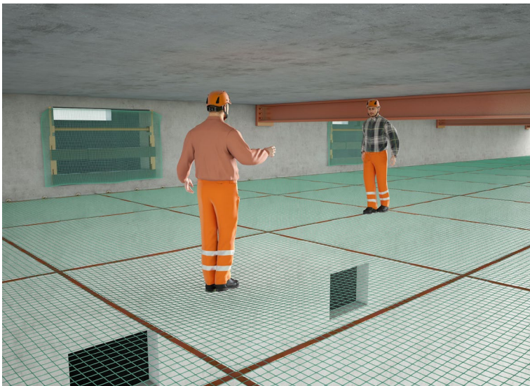
Abb. 4 max. 1,50 m unterhalb der Konstruktion (Quelle: Baustein B 105)
