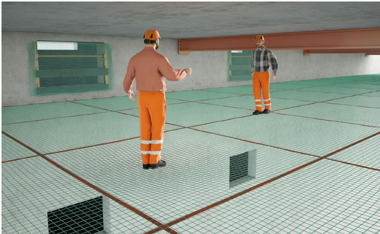
Abb. 1 Montiertes Arbeitsplattformnetz in einer Stahl-/Betonkonstruktion
