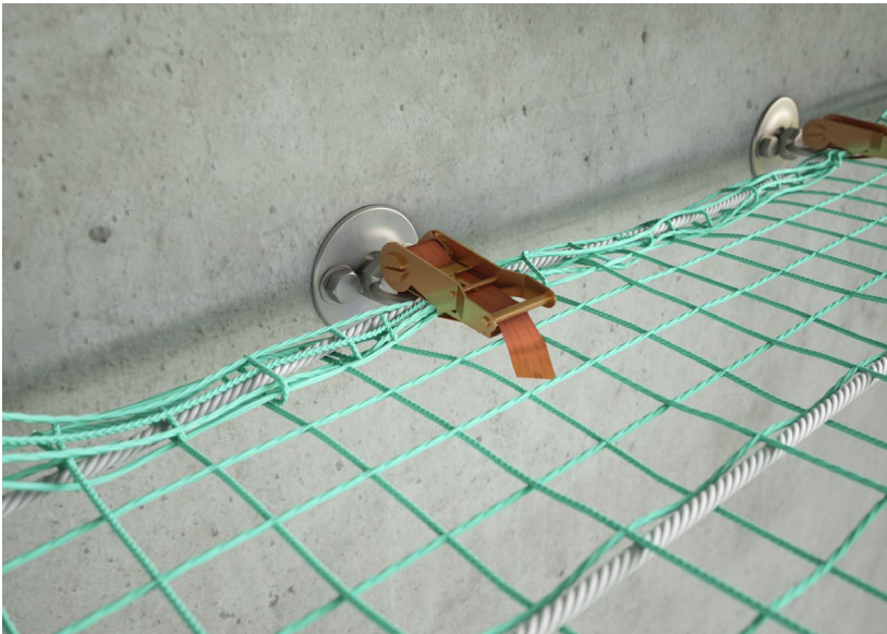
Abb. 12 Montage mit Schwerlastanker und Ringschrauben an Betonfertigteilen
