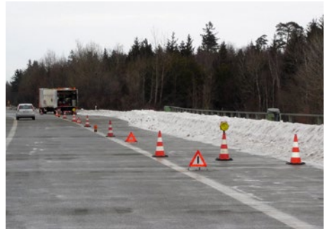
Abb. 13 Absicherung einer Einsatzstelle
