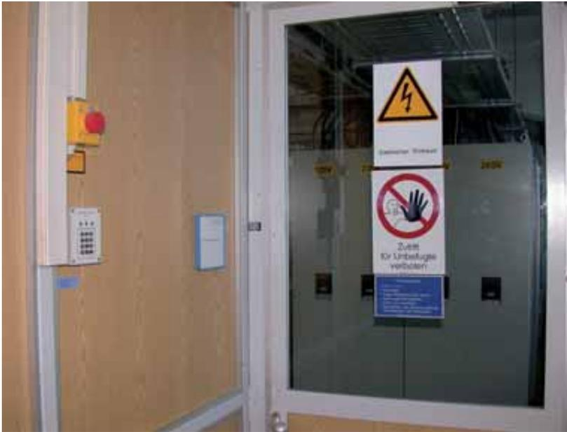
**Bild 9** Zugang zu einem Dauerversuchsraum, Kennzeichnung der Zugangstüre, Zugang mittels codierter Türverriegelung nur für befugtes Personal
