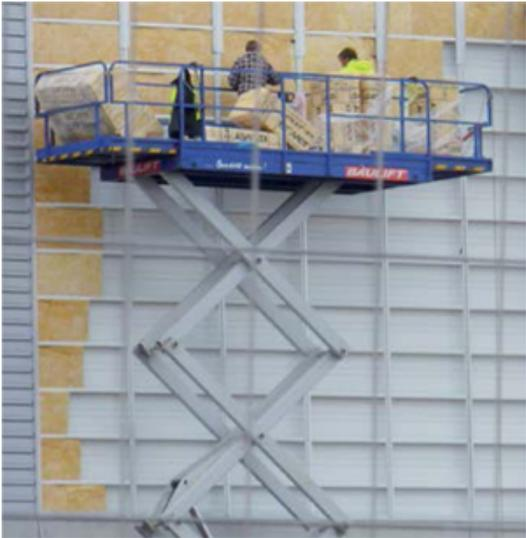
Bild 7-2: Transport und Montage von Isoliermatten
