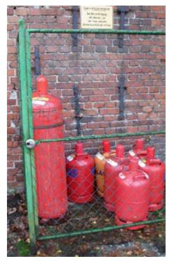
Abb. 8-2 Lagerung gefüllter Druckgasbehälter im Freien
