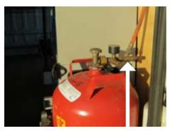
Abb. 6-3 Schlauchbruchsicherung
