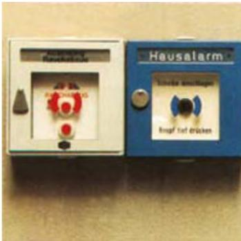
Bild 11-8: Druckknopfmelder für Hausalarm und zur Ansteuerung von Rauch- und Wärmeabzügen
