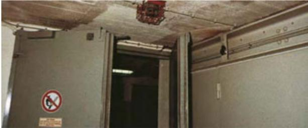
Bild 11-7: Meldergesteuertes Türmagnetsystem für selbstschließende Tür mit Schließfolgeeinrichtung als Brandabschluss für einen Raum zur Lagerung brennbarer Flüssigkeiten
