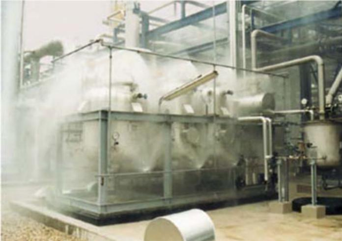
Bild 11-29: Einsatz einer Sprühwasserlöschanlage
