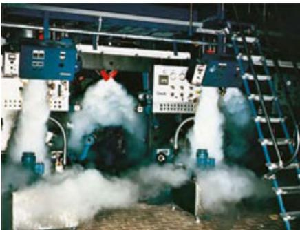
Bild 11-30: Stationäre CO<sub>2</sub>-Löschanlage an einer Druckereimaschine während des Flutens
