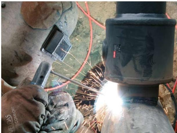
Aufschweißen eines Anbohrkugelhahns DN 100 auf eine abisolierte Fernwärmehauptleitung DN 150; Betriebsparameter: Vorlauf ca. 90° C, 5 bar.
