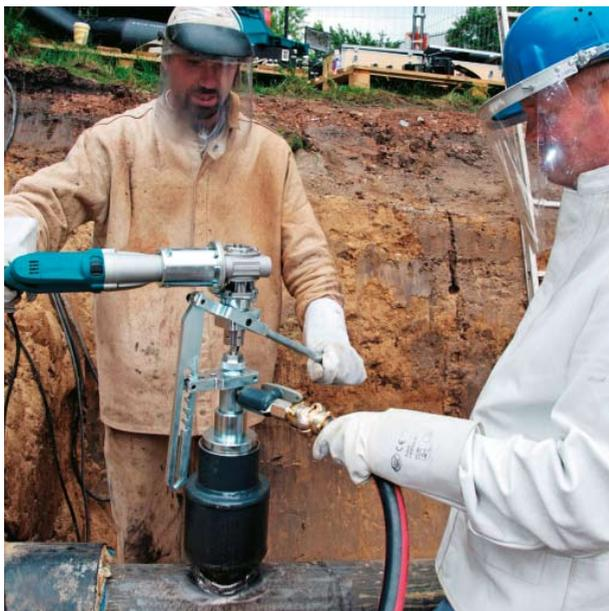
Anbohrung einer abisolierten Fernwärmehauptleitung DN 150 mit dem Danfoss Anbohrsystem Typ Jip; das Anbohrsystem besteht im wesentlichen aus dem Anbohrkugelhahn DN 100, dem Anbohrgerät mit Spülanschluss, dem Bohrständer mit der Vorschubeinstellung von Hand, dem Winkelgetriebe und der elektrischen Bohrmaschine; Betriebsparameter: Vorlauf ca. 90° C, 5 bar.
