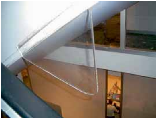
Bild 3: Einzugsgefahr durch zu kurze Abweiser
