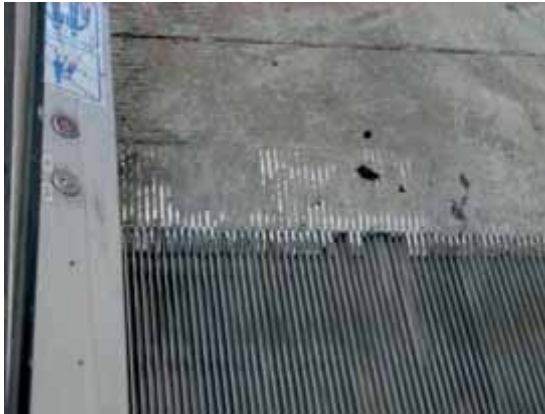
Bild 18: beschädigter Kamm
