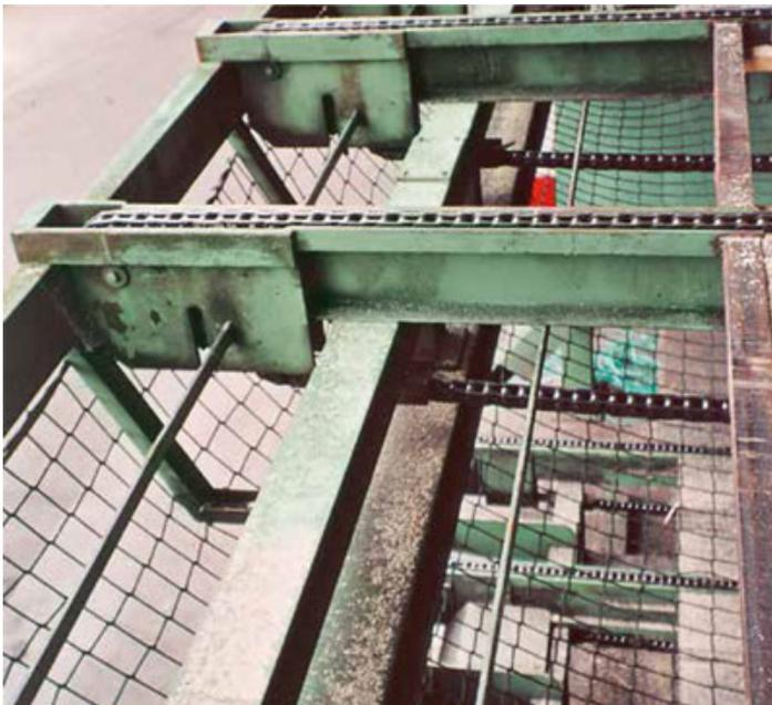
Bild 46: Netz als Absturzsicherung an erhöhten Stapelbereichen
