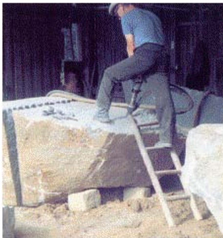
Abb. 33: Sicherer Zugang und Unterfütterung des Rohblocks
