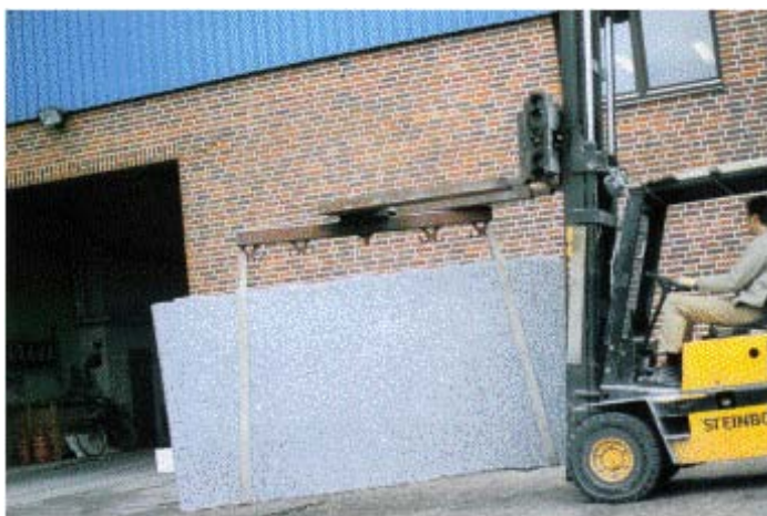
Abb. 18: Plattentransport mit Stapler und Hebebändern
