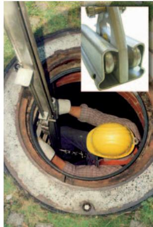
**Bild 9:** Steigleiter mit Mittelholm, Steigschutzeinrichtung und steckbarer Haltevorrichtung
