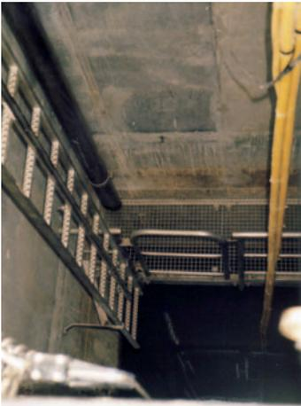
**Bild 8:** Steigleiter mit Seitenholmen, Steigschutzeinrichtung und Podest
