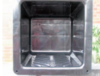
**Bild 7:** Steigkasten ohne Festhaltungsmöglichkeit
